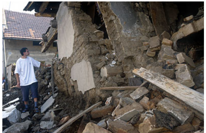
République tchèque août 2002. Des maisons en pisé se sont effondrées dans de nombreux villages de cette région du Nord de la Bohême. Photo : Andrew MacColl/Fédération internationale
